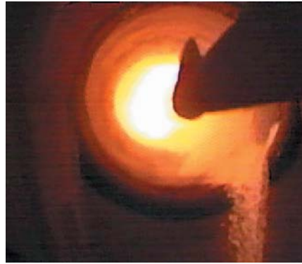
FlameSightVideo Bild aus einem Drehrohrofen (Zementindustrie) FlameSightVideo picture from a rotary kiln (cement industry)
